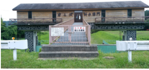
岩之沢排水樋門
